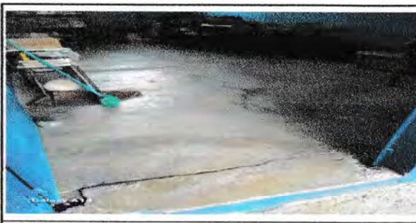
Foto 5: Piso aula No. 3 esta aula posee una division de por medio del aula y no esta del mismo nivel de igual forma tiene grietas en toda el aula y da el mismo problema que la tierra sale por las grietas.
